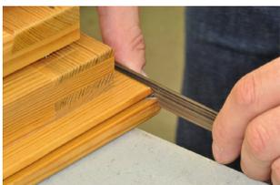
Вставить уплотнитель в паз до места отрезания
